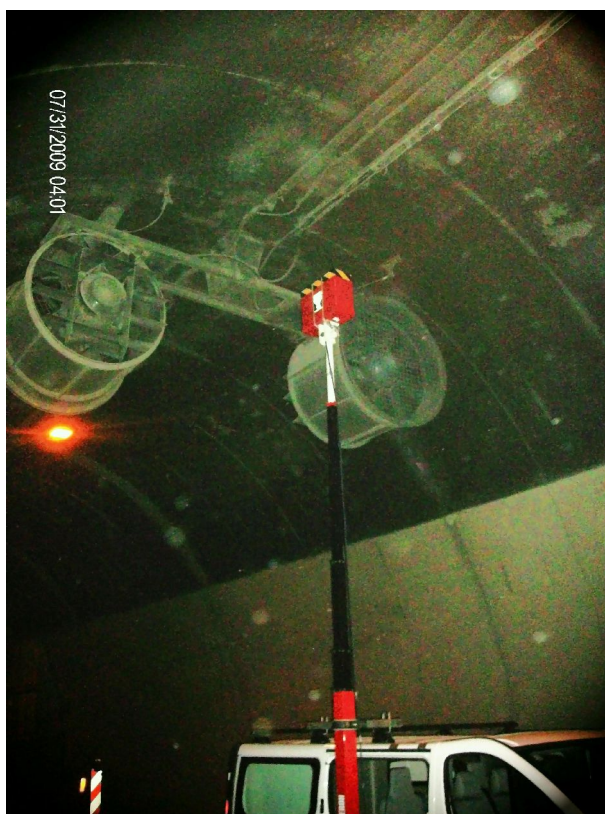
Обделка тунеля быстро может быть обследована с вытянутой мачтой, установленной на автомобиль.
